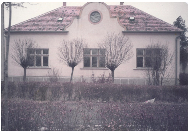
Rábatamási Önkormányzat épülete
